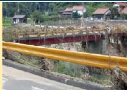
氾濫時の流木やゴミが橋を覆う
